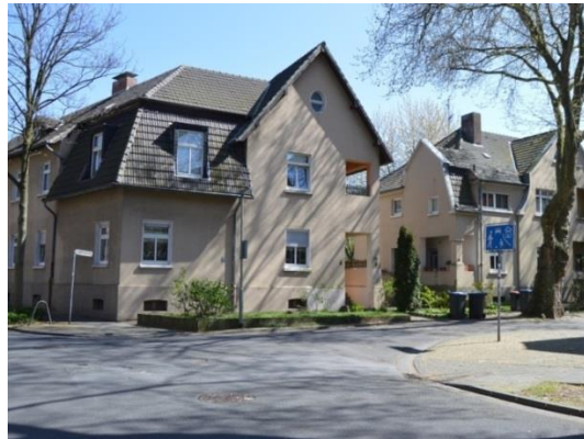
Abbildung 2: Eckhausbebauung an der Stollenstraße
